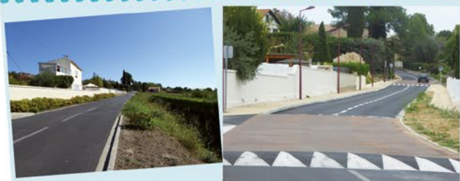
RD 33 avant et après travaux
